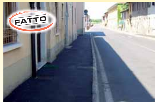
«Sistemazione del marciapiede in via Mazzini a Pievedizio, dove in questi giorni si stanno anche sistemando le aiuole»
